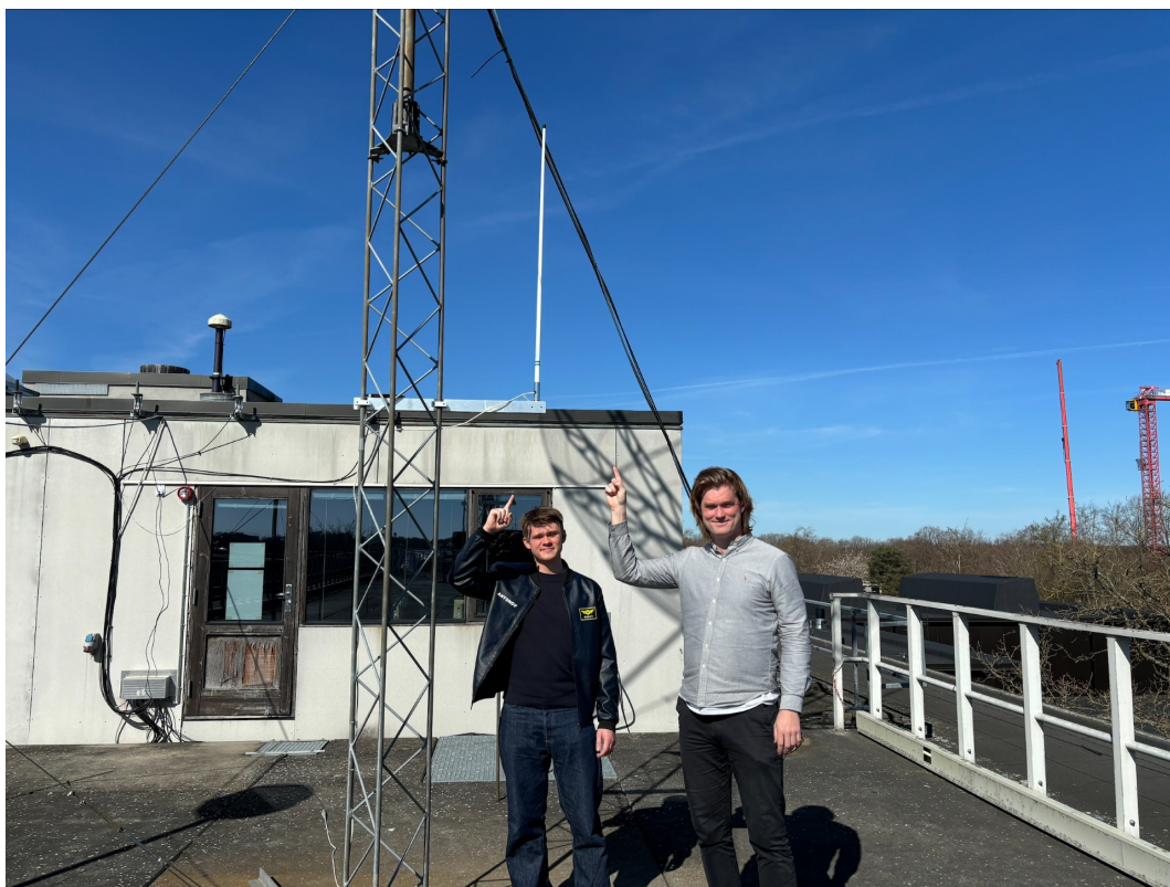
Figur 1: Antenne på toppen af DTU Bygning 348. Antennekablet løber ind i bygningen, hvor SDR og Raspberry Pi er placeret.
